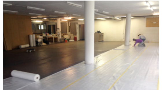
Freiwillige, Vorstand, das Wohnheim-Team und einzelne Bewohnende renovierten im Frühling 2016 die Brocki-Räume in Celerina.
